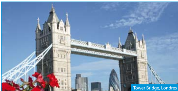
Tower Bridge, Londres
